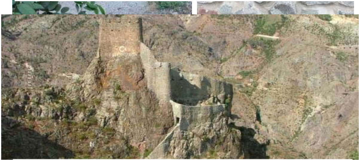
Resim 8. Artvin Kalesinin gney cephesi grnř
