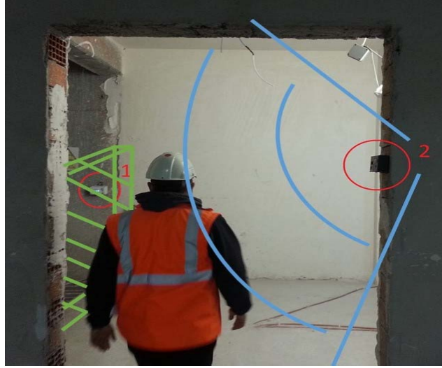
Şekil 6. RFID Şantiye Örnek Kullanım Alanı [25]
