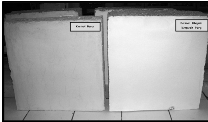
Şekil 3. Harç örneklerinin duvar üzerindeki uygulamalarından genel bir görünüm
