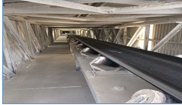
Şekil 2. Kardemir A.Ş tesisi konveyör bant galerisi [11].
